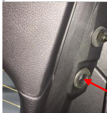
2.7 安装进线胶塞, 线把原车胶塞拆除
